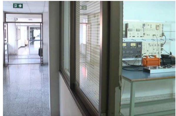
รูปที่ 10 การติดตั้งป้าย Exit ทางออกเดินชุด
